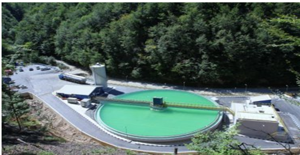
Сн. 1. Пречиствателна станция за отпадъчни води по проект на ММТЕС
